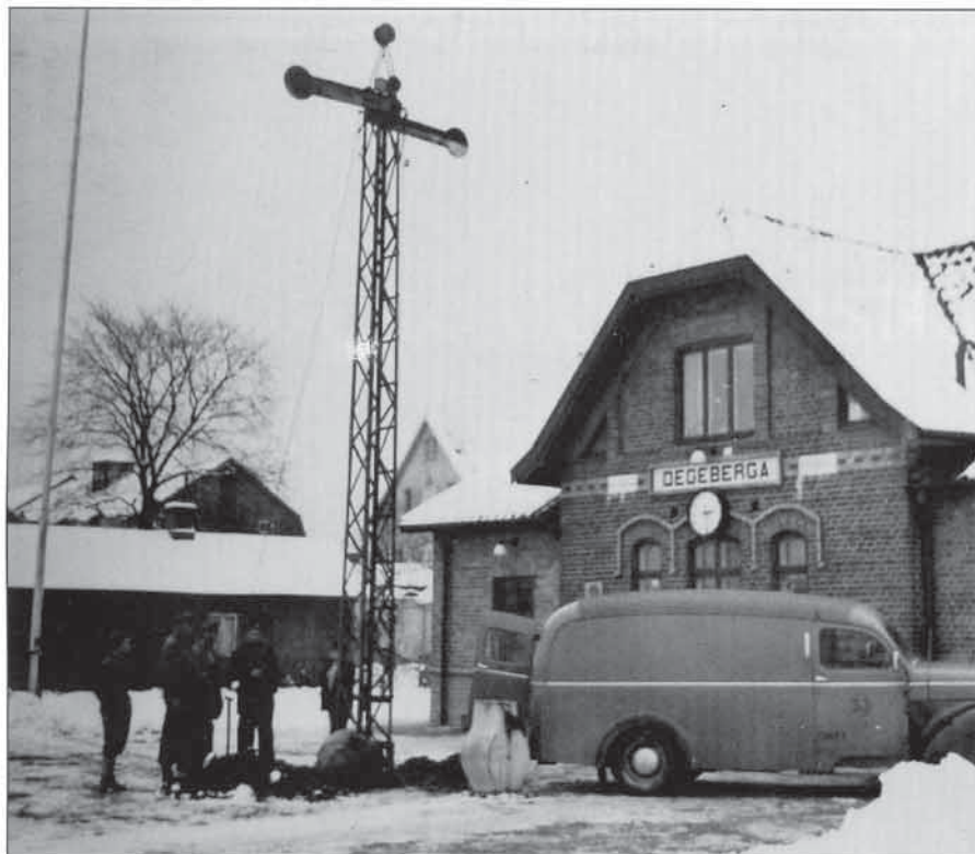
Semafören vid Degeberga järnvägsstation revs i början av 50-talet och ersattes med modernare signalteknik.
