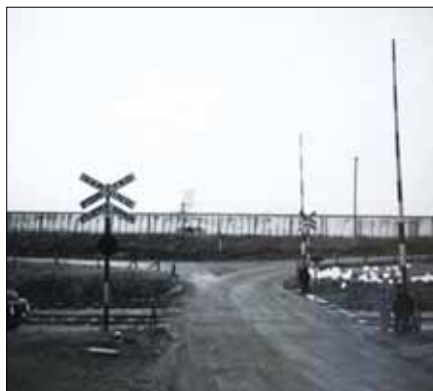
Fällbomsförsedd plankorsning 200 m söder om stationshuset, fotograferad 1957. Bomarna sköttes av stationspersonal, och när stationen var stängd tjänstgjorde vakt.
